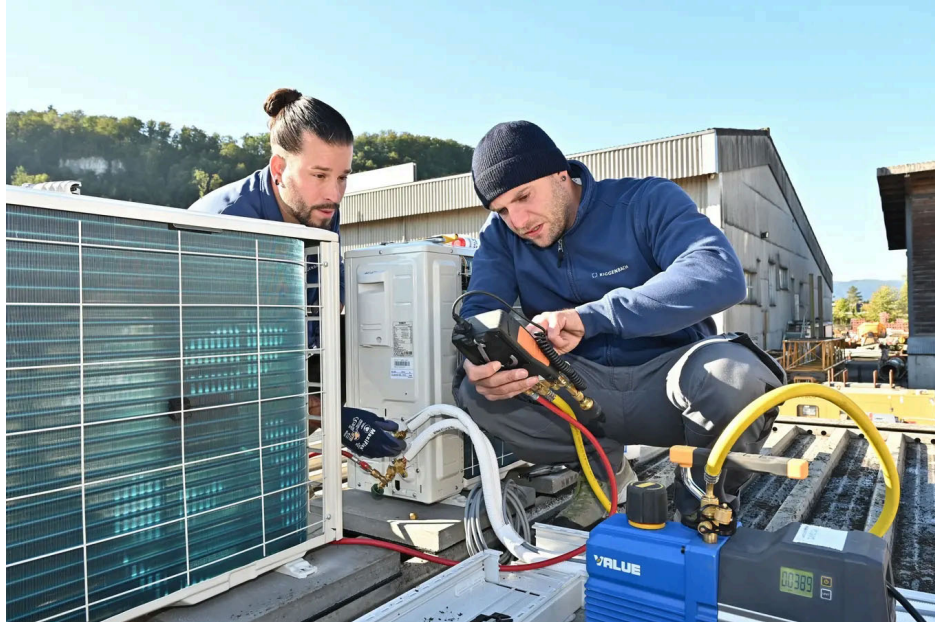
Kältetechniker der Riggenbach AG montieren eine Klimaanlage.
